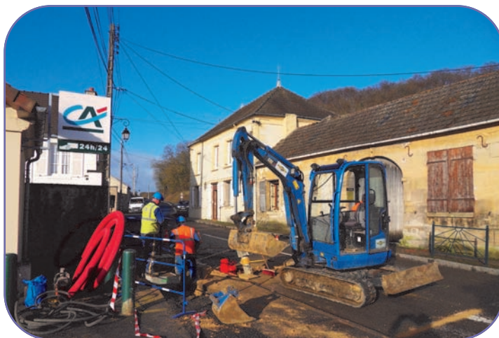
Enfouissement des réseaux Place Tainturier
